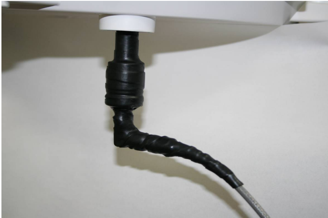
図 5 - 8 自己融着テープ巻き付け完了
