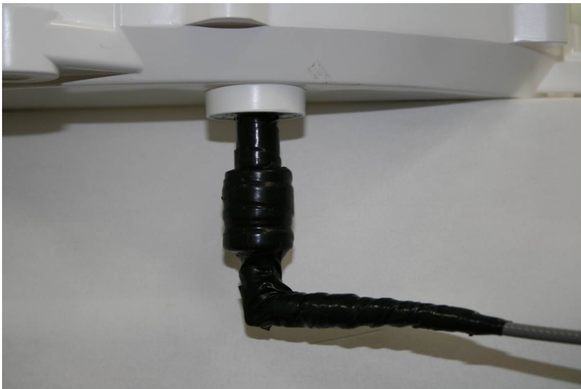
図 5 - 1 0 ビニールテープ巻き付け完了
